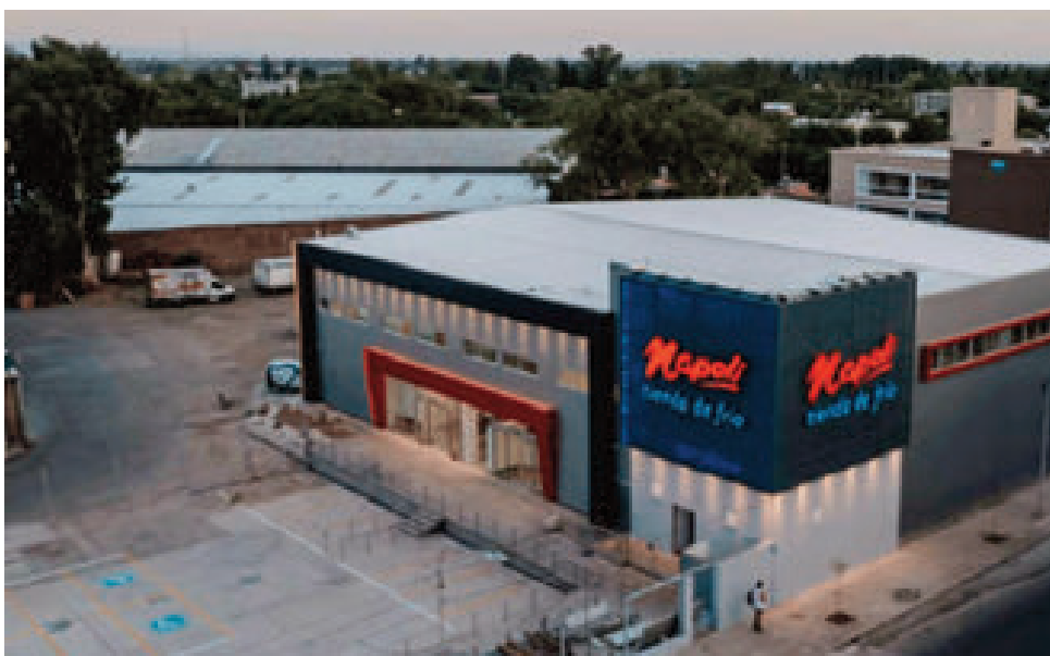
Vista aérea del nuevo emprendimiento.
