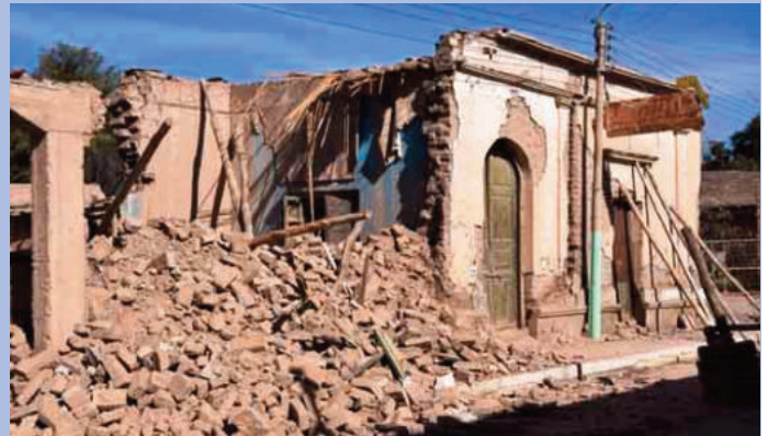
En agosto del 2019, comenzó la demolición de la tradicional casona.
