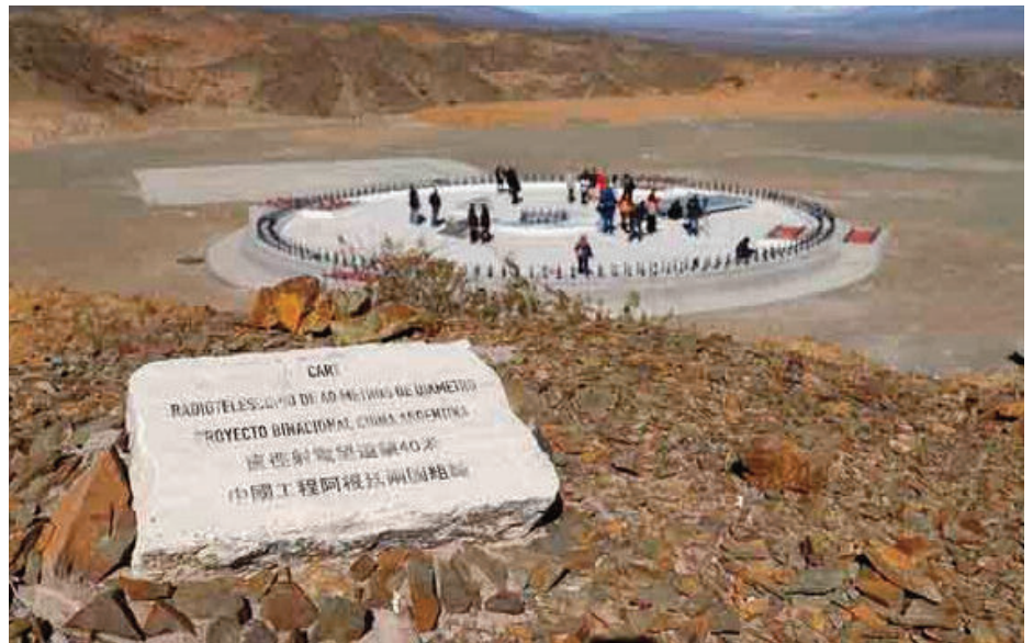
Días atrás en Barreal se culminó con la construcción de la base en la que se instalará la antena.
