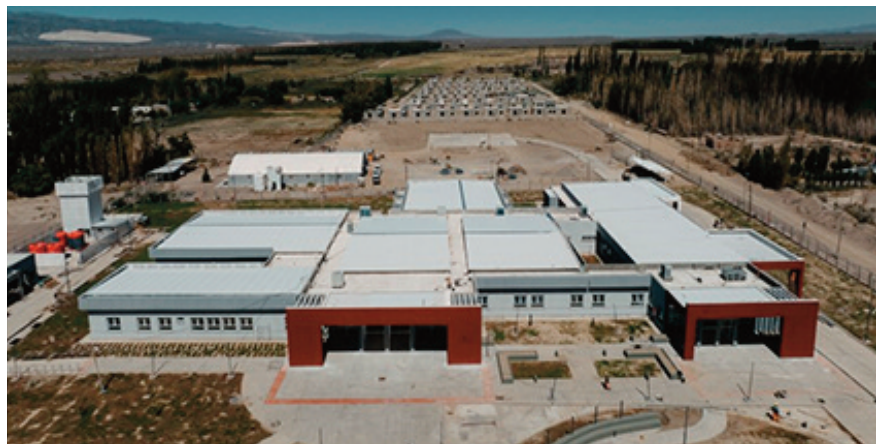
El hospital de Iglesia está en construcción.
