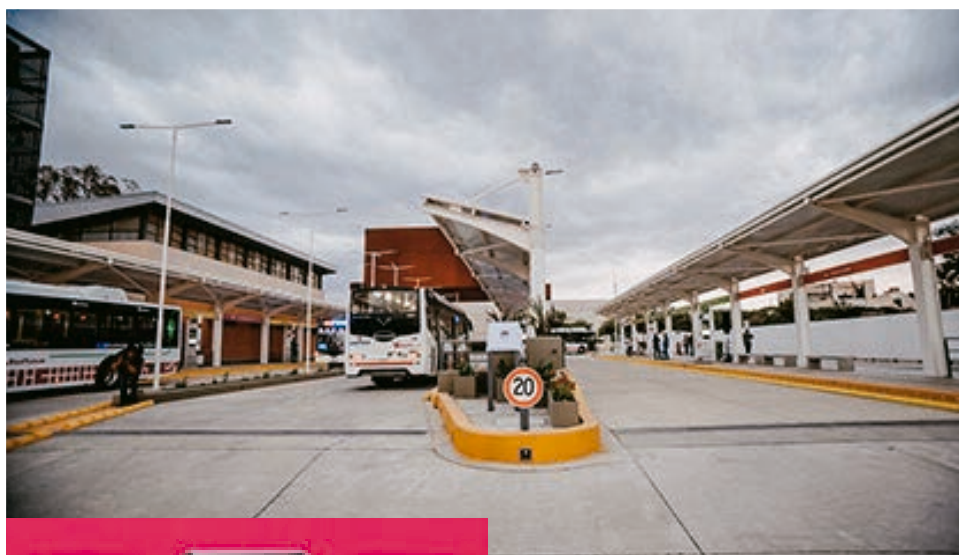
Una de las estaciones de trasbordo está en avenida Córdoba, la otra por calle Mitre.
